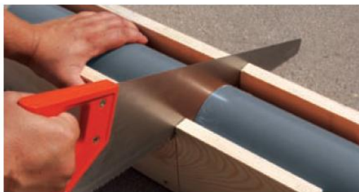
Obrázek 2 Úkos dodatečně zkrácené trubky
